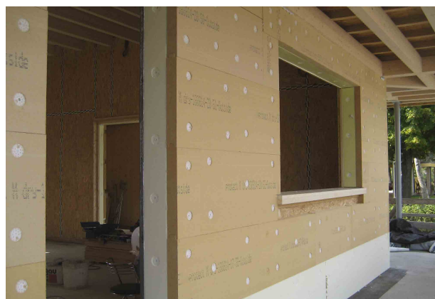
Il sistema di isolamento termico è raccomandato sia nelle nuove costruzioni che nelle ristrutturazioni. Migliora le prestazioni energetiche e consente l'abitabilità durante l'installazione.
